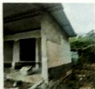
Foto 11: MODULO DE SERVICIO SANITARIO. desmontaje de cubierta de lámina de zinc, vista de cubierta de lámina troquelada cal 26 y estructura de metal. Aplicación de acabados en muros.
