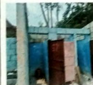
Foto 9: MODULO DE SERVICIO SANITARIO. Vista Frontal proceso de desmontaje de cubierta de lámina de zinc, vista de instalación de cubierta de lámina troquelada cal 26 y estructura de metal. Aplicación de acabados en muros.
