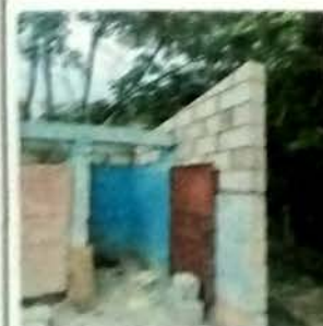
Foto 11: MODULO DE SERVICIO SANITARIO. desmontaje de cubierta de lámina de zinc, vista de cubierta de lámina troquelada cal 26 y estructura de metal. Aplicación de acabados en muros.
