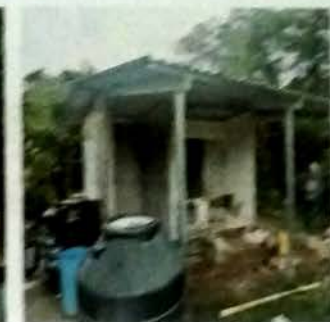
Foto 8: MODULO DE SERVICIO SANITARIO. Vista Frontal proceso de desmontaje de cubierta de lámina de zinc, vista de instalación de cubierta de lámina troquelada cal 26 y estructura de metal.
