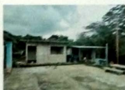
Foto 12: MODULO DE SERVICIO SANITARIO. Vista Frontal de desmontaje de cubierta de lámina de zinc, vista de cubierta de lámina troquelada cal 26 y estructura de metal. Aplicación de acabados en muros.
