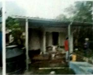
Foto 10: MODULO DE SERVICIO SANITARIO. Vista Frontal proceso de desmontaje de cubierta de lámina de zinc, vista de instalación de cubierta de lámina troquelada cal 26 y estructura de metal. Aplicación de acabados en muros.
