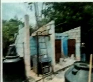
Foto 8: MODULO DE SERVICIO SANITARIO. Vista Frontal proceso de desmontaje de cubierta de lámina de zinc, vista de instalación de cubierta de lámina troquelada cal 26 y estructura de metal.
