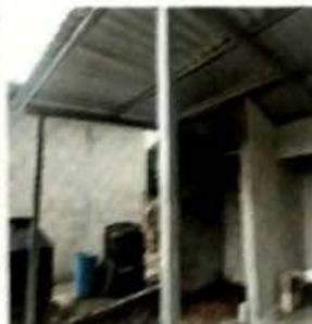
Foto 9: MODULO DE SERVICIO SANITARIO. Vista Frontal proceso de desmontaje de cubierta de lámina de zinc, vista de instalación de cubierta de lámina troquelada cal 26 y estructura de metal. Aplicación de acabados en muros.
