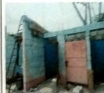
Foto 10: MODULO DE SERVICIO SANITARIO. Vista Frontal proceso de desmontaje de cubierta de lámina de zinc, vista de instalación de cubierta de lámina troquelada cal 26 y estructura de metal. Aplicación de acabados en muros.
